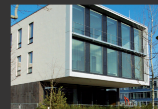
Kancelárska budova Mníchov ■ statická skúška a skúška stavebných konštrukcií
