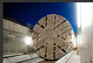
Tunel Finne ■ vedenie stavby, miestny stavebný dozor
