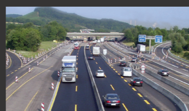
A.6 Diaľničná križovatka Weinsberg ■ miestny stavebný dozor
