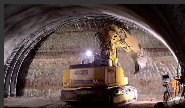
Tunel Jagdberg ■ vedenie stavby, miestny stavebný dozor, zameranie stavby
