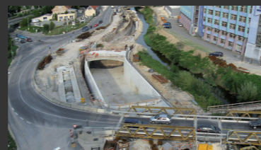
Cestný tunel Schwäbisch Gmünd ■ projektové plánovanie, inžinierske stavby, návrh nosných konštrukcií, technické vybavenie, stavebný dozor a vedenie stavby, bezpečnostný referent podľa smernice 2004/54/ES
