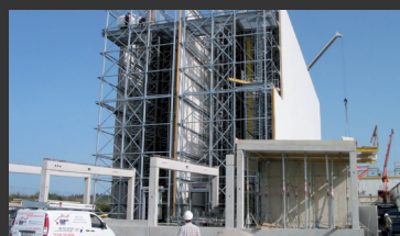
Výškový regálový sklad Alpenhain ■ statické skúšky a skúška stavebných konštrukcií
