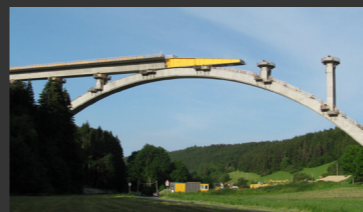
Viadukt Truckerthal ■ vedenie stavby, inžinierske stavby, miestny stavebný dozor
