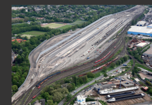
Novostavba vlakovej stanice a Nová budova otočiska v stanici Duisburg-Ruhrort Hafen ■ riadenie projektu, materiálová logistika
